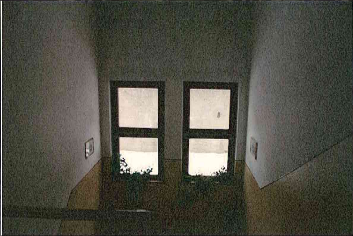
Particolare vano scala
