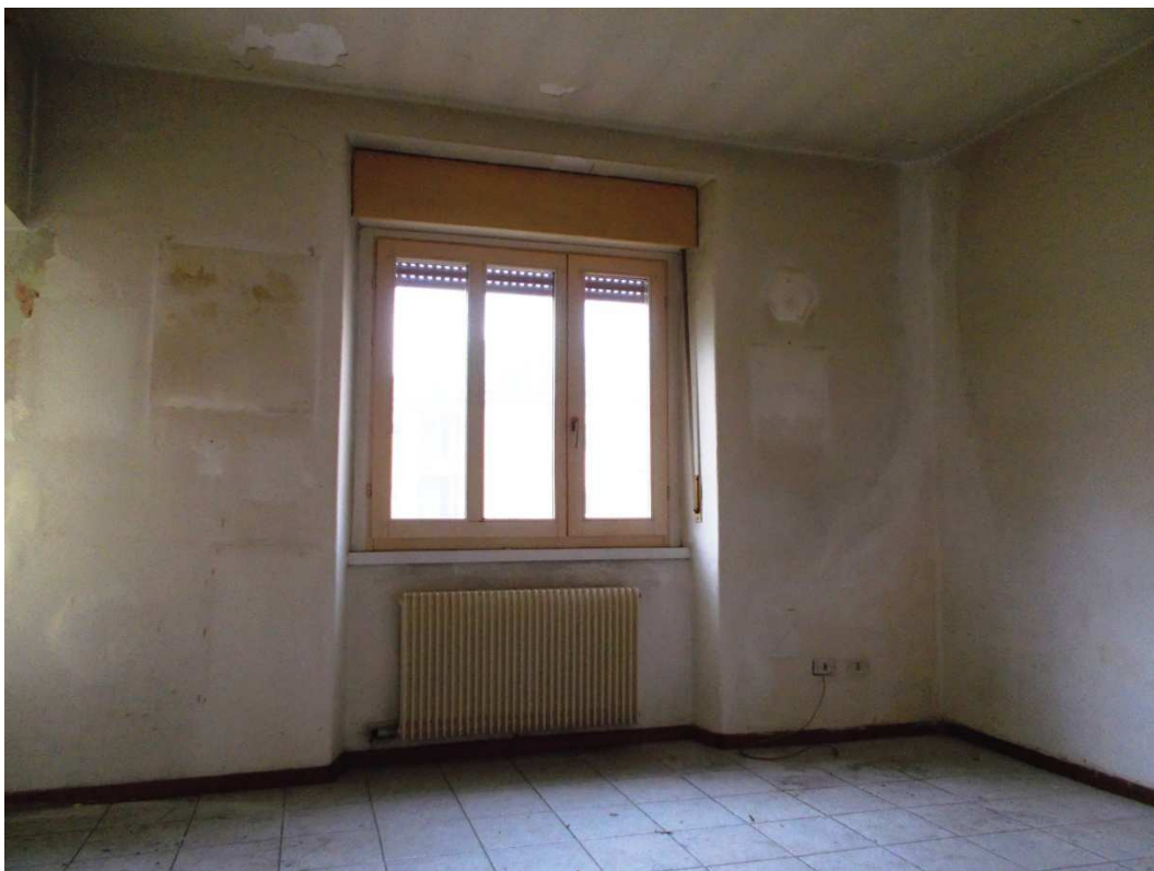
Vista locale cucina con finestra verso est.
