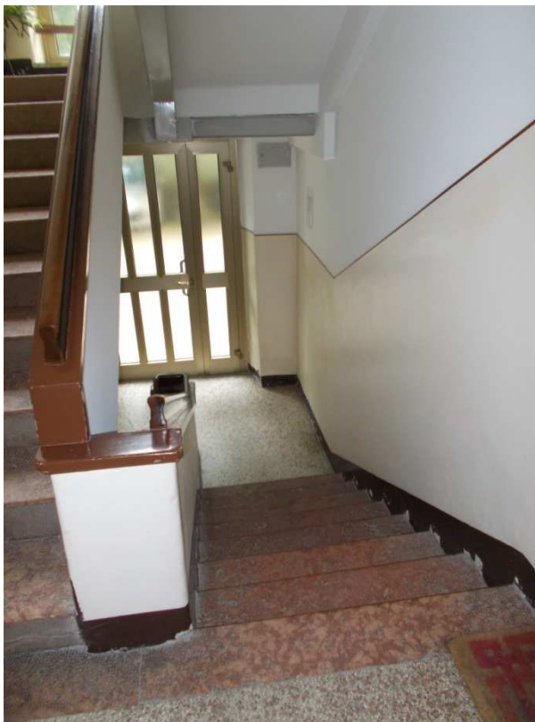
Particolare vano scala con ingresso da cortile
