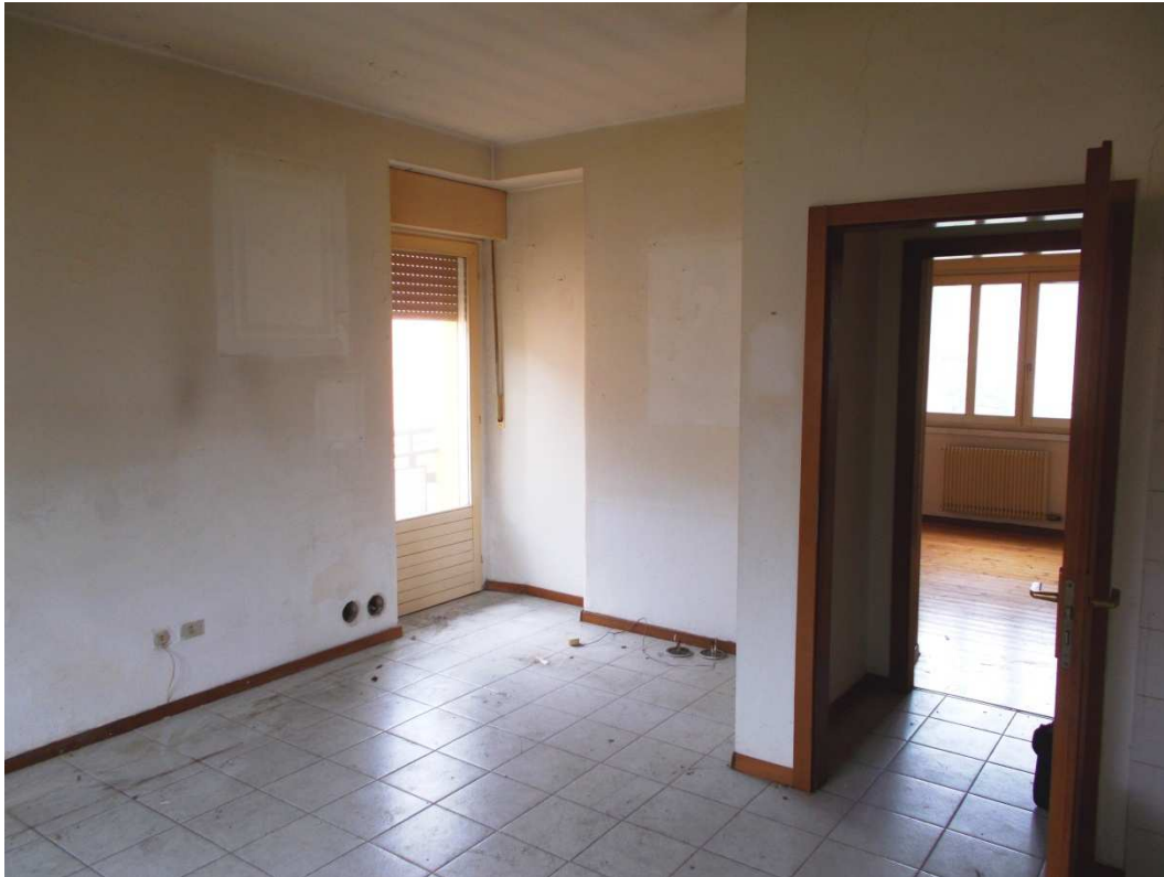
Vista locale cucina con portafinestra di accesso su balcone facciata sud.
