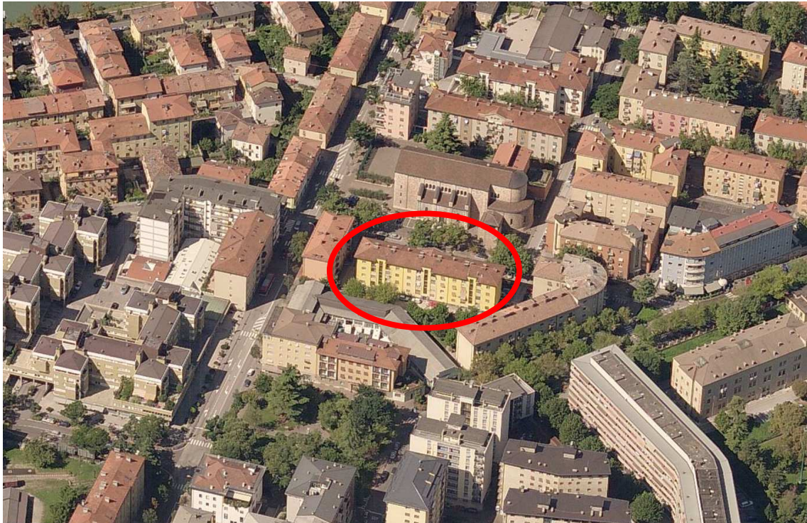
Veduta aerea verso ovest dell'immobile inserito nel contesto del quartiere di Cristo Re. Foto estratta dal sito cartografia generale del Comune di Trento.
