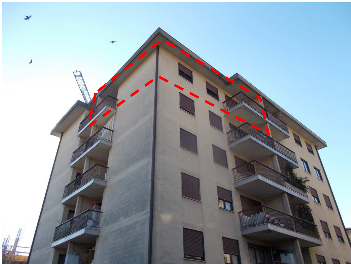
Localizzazione alloggio a quinto piano; serramenti e balconi con esposizione nord/est e nord/ovest.
