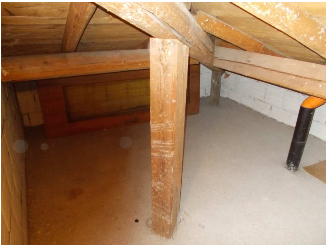
Vista soffitta a piano sottotetto.
