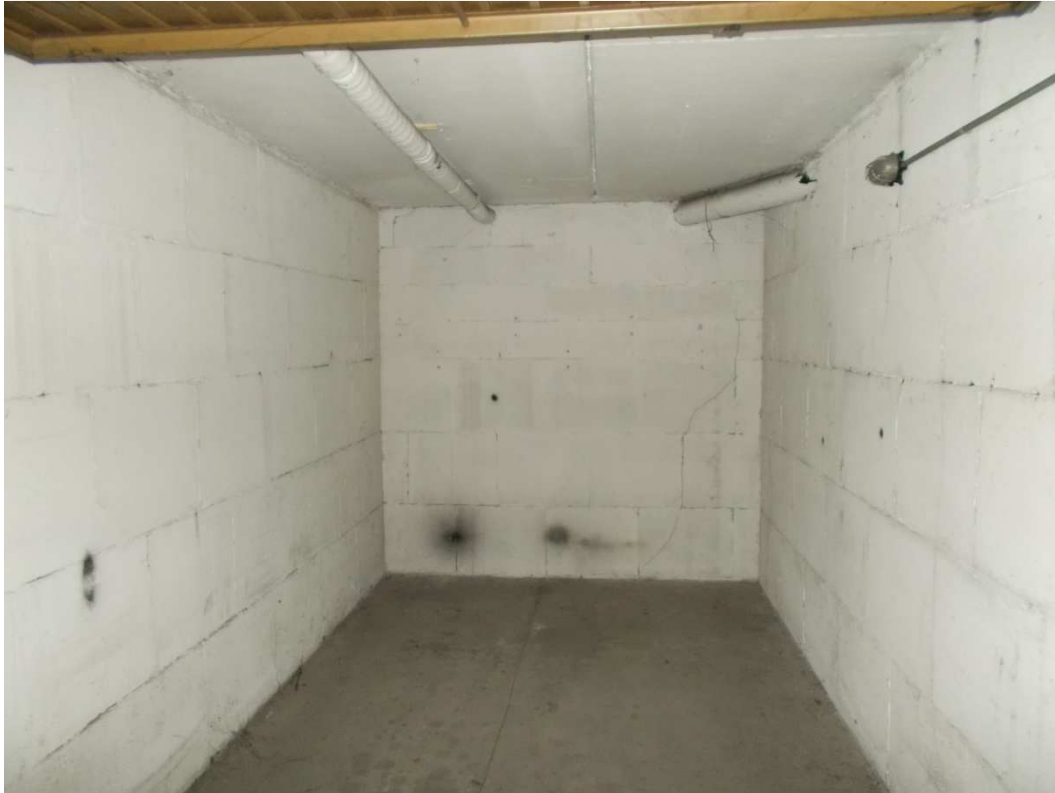
Vista garage a piano interrato.
