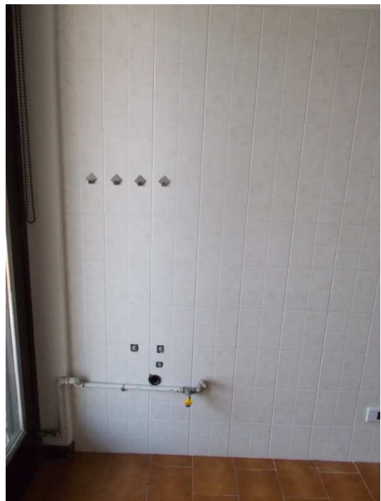
parete zona cottura con attacchi gas e acqua
