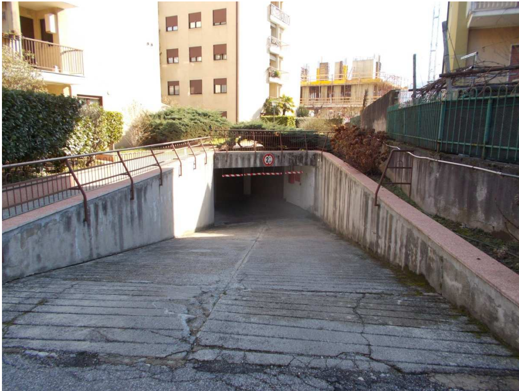
Rampa accesso a garage interrato.
