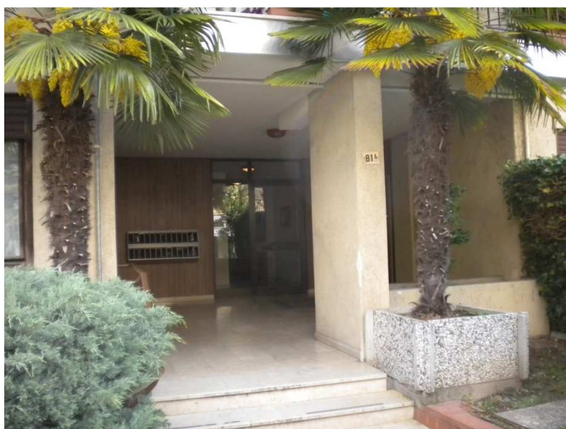
Vista atrio porticato antistante ingresso a vano scala civico 81/A.
