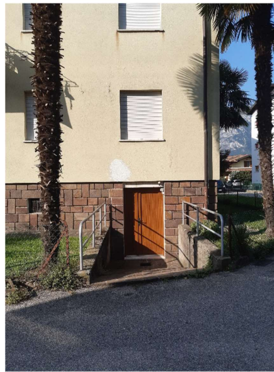
Prospetto nord-est – portoncino d'ingresso al deposito comune del piano seminterrato
