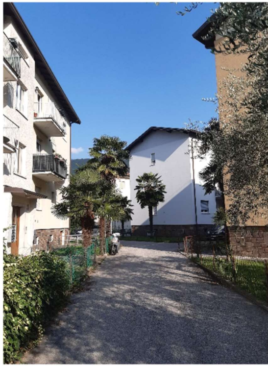
Prospetto nord-est – portoncino d'ingresso
