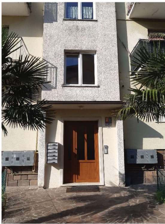
Prospetto nord -est e vialetto di accesso
