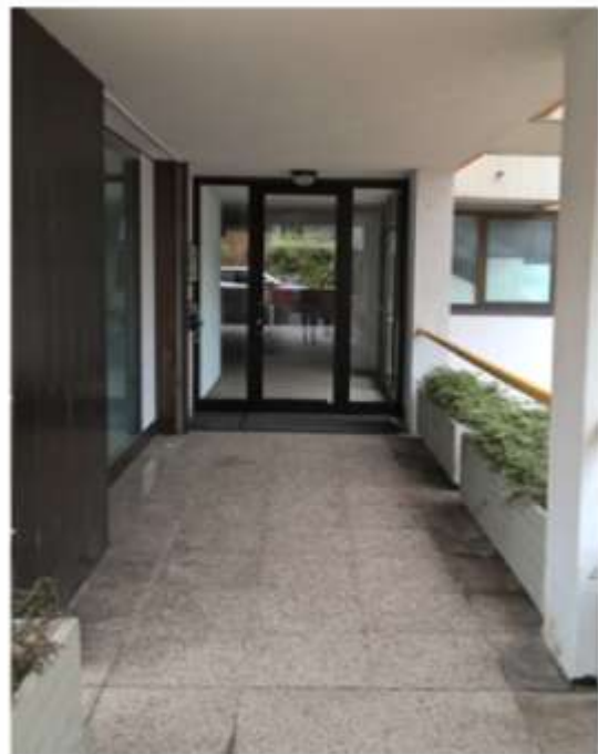
-Vista dell'ingresso su via Ghiaie
