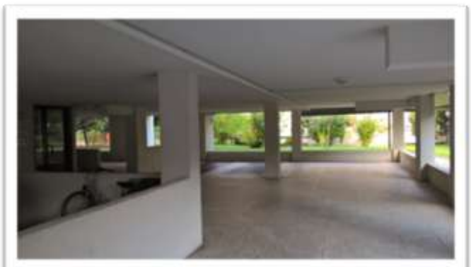
-Vista dell'accesso alla scala F all'interno del complesso -Vista del portico in corrispondenza dell'ingresso alla scala F
