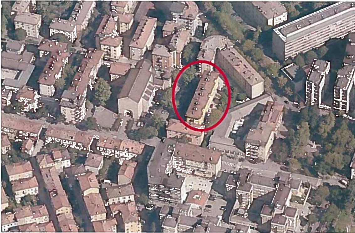
Veduta aerea verso nord dell'immobile inserito nel contesto del quartiere di Cristo Re. Sulla sinistra è visibile la piazza e la chiesa rionale. Foto estratta dal sito cartografia generale del Comune di Trento.
