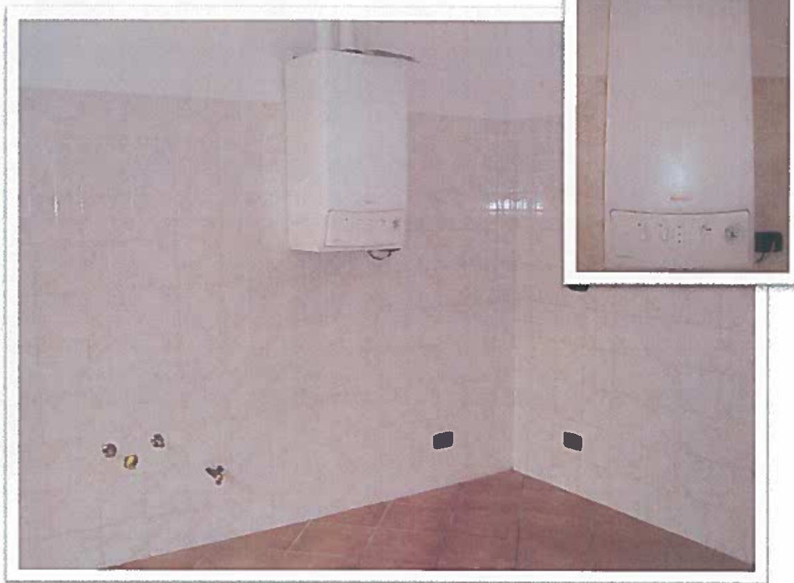
Vista dell'angolo cottura e particolare caldaia.
