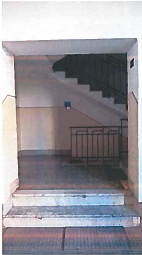
Particolare accesso al vano scala dal piano terra
