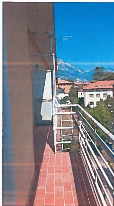
Foto del balcone lungo il lato est
