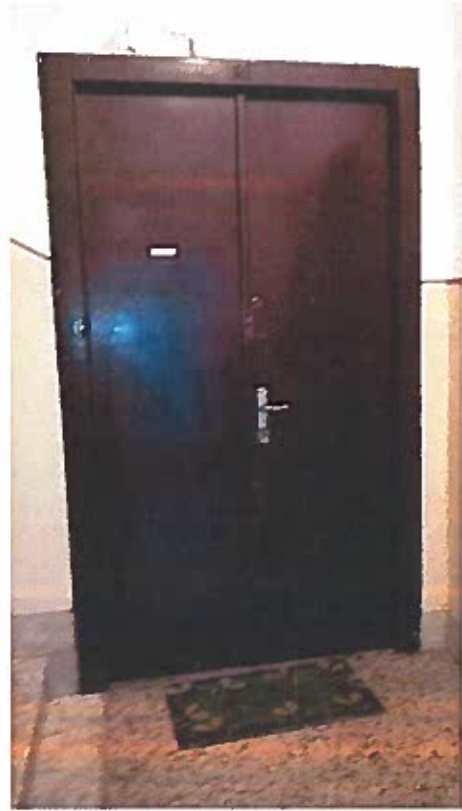
Particolare ingresso verso corridoio comune alle pp.mm. 18-25 (primo ingresso)
