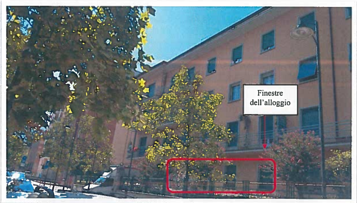
Vista del prospetto principale su via G. a Prato
