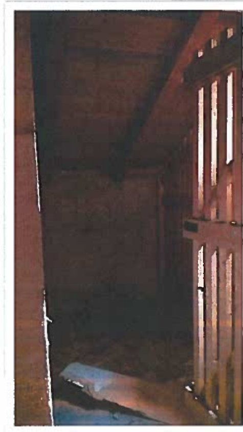
Vista della soffitta
